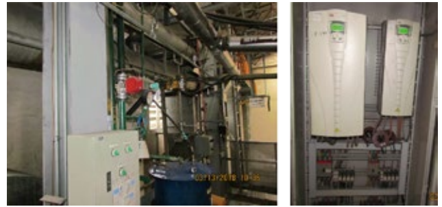
顺德场地在泵上安装变频器节能
